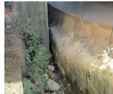
fig. 7 il canale di scolo
