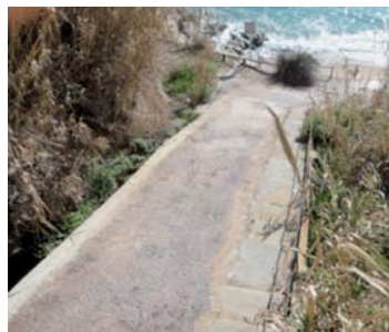
fig. 6 lo sbocco a mare
