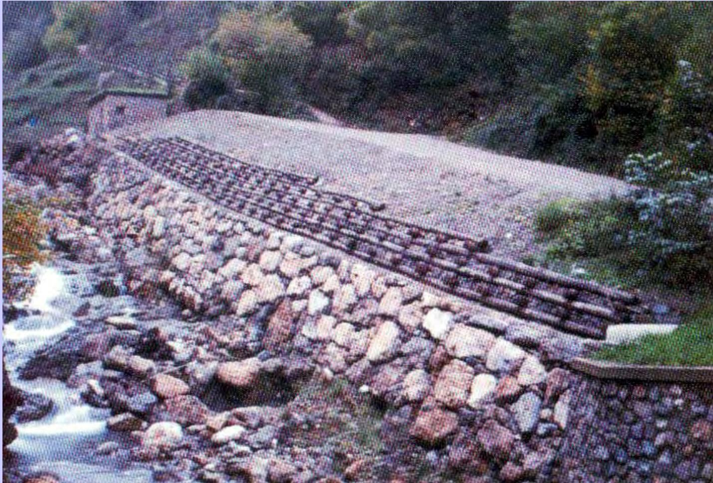
La foto mostra che il muro sarà ben presto scalzato ed eroso completamente dal corso d'acqua, che è dotato (vedi i sedimenti in alveo) di una competenza sicuramente paragonabile alla dimensione media dei massi con cui è stato realizzato il muro a secco...
